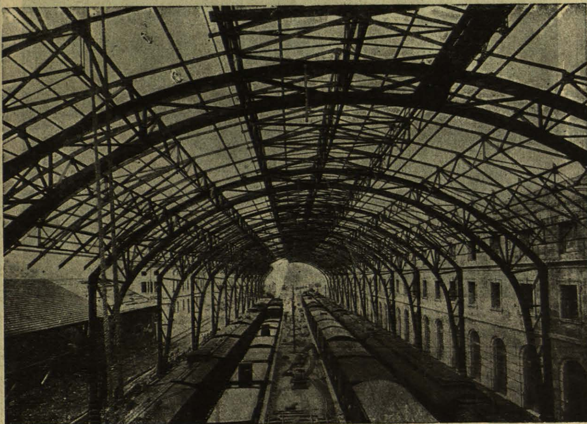
Estación internacional de Port-Bou.—Cubierta de andenes.—Agosto-Diciembre 1928.
